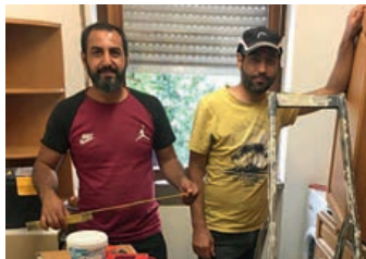
Hamman (l.) und Emad beim Einbau der Küche. Foto: privat
